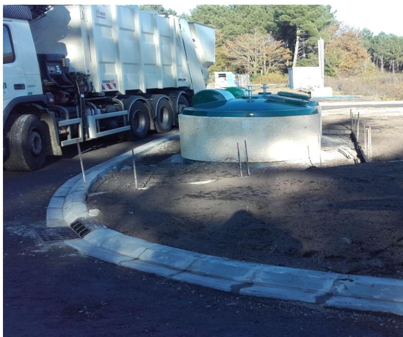
Photo d'un test avec camion suite à l'implantation de conteneurs semi enterrés
