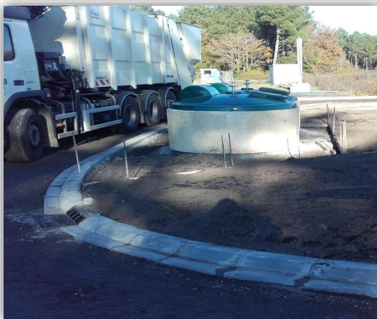
Photo d'un test avec camion suite à l'implantation de conteneurs semi enterrés
