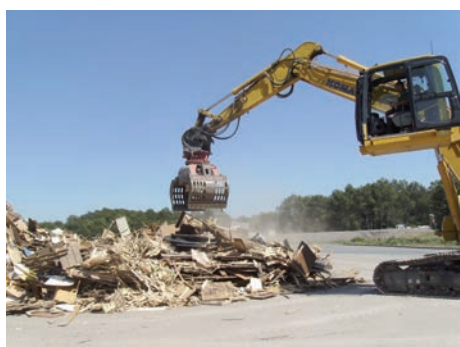
À LA PLATE-FORME : tri à la pelle des déchets de la benne "bois"
