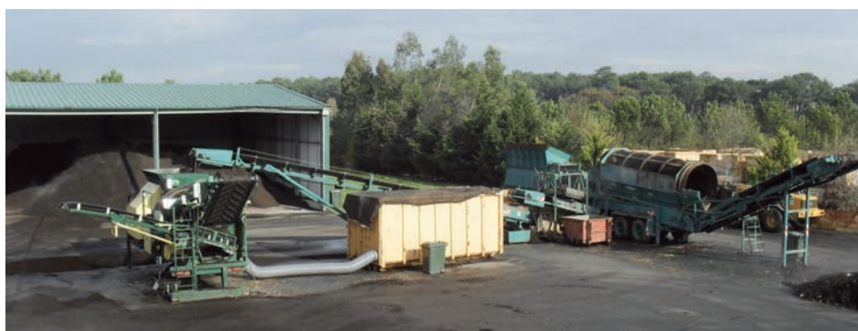
Criblage sur la Plate-forme de compostage de Bénése Maremne
