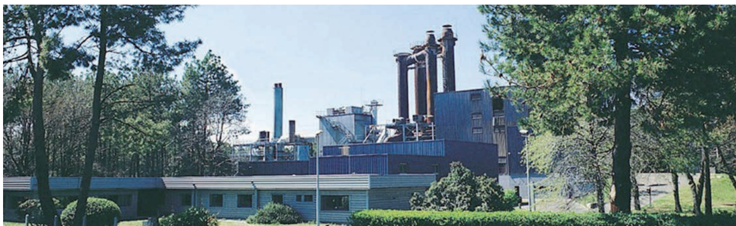
Actuelle usine d'incinération de Bénesse Maremne
