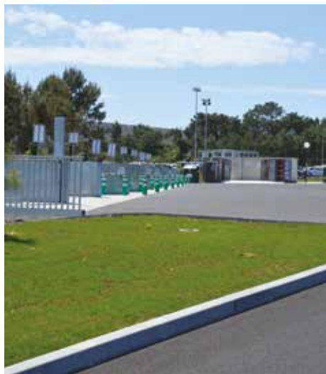
Déchetterie de Tarnos
