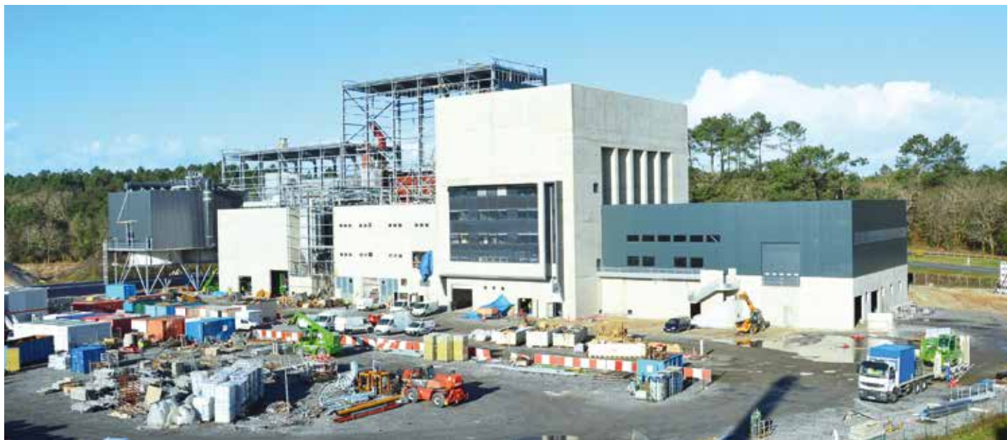
Mise en place de la toiture
